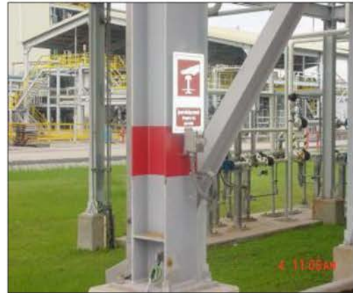
ภาพที่ 2.2-21 ปุ่มกดแจ้งเหตุสัญญาณฉุกเฉิน
