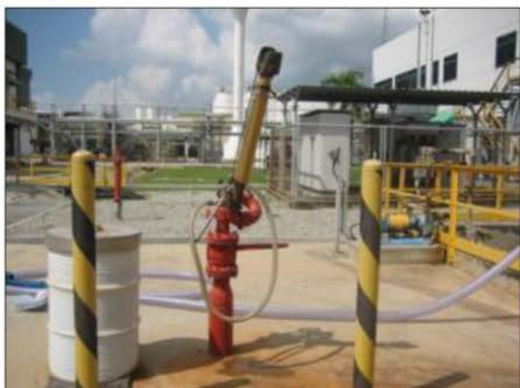
Monitor Gun และถังน้ำยาโฟมดับเพลิง
